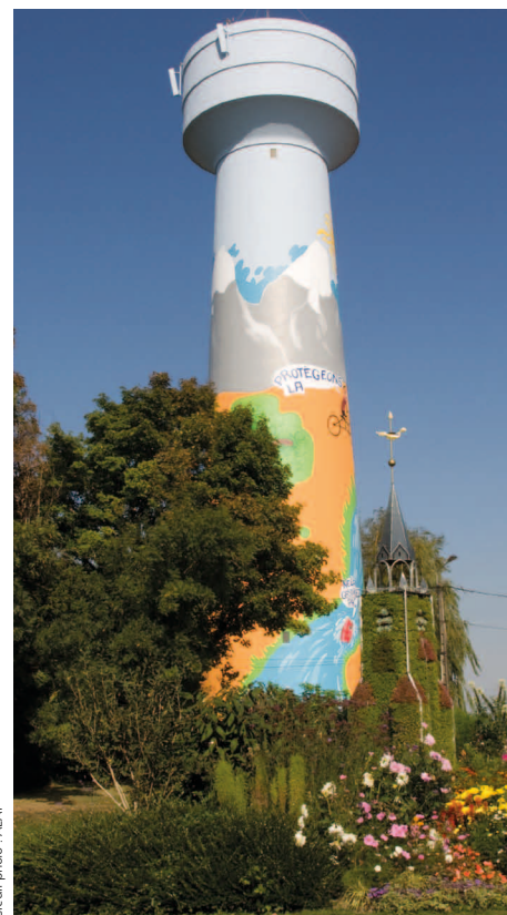
Le château d'eau permet de stocker l'eau potable après traitement et avant distribution.
