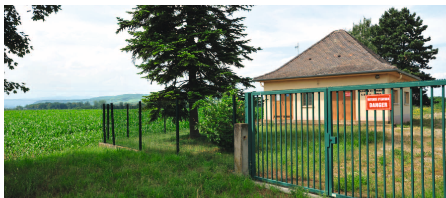
Captage d'eau potable
